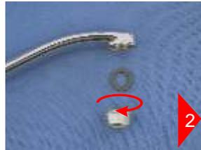
**2** Am Wasserhahn befindlichen Strahlregler abschrauben (geeigneten Schraubenschlüssel verwenden). Vorhandenen Dichtring unbedingt mit entfernen.
