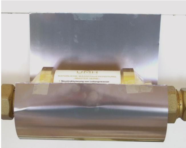
Zum Schutz vor **elektrischen und magnetischen Feldern**, die durch diverse elektrische Geräte, wie Pumpen, Aggregate, Starkstromleitungen u.w.m. entstehen, sollten die UMH-Wasseraufbereitungsgeräte mittels einer MU-Abschirmfolie ummantelt werden.
